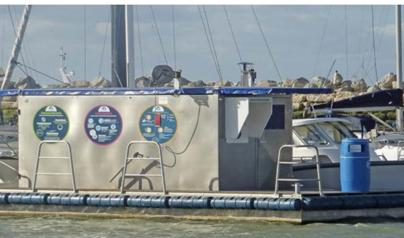
Station de lavage écologique eau désalinisée / Haute pression / Savon biodégradable Stazione di lavaggio ecologica acqua desalinizzata / Alta pressione / Sapone biodegradabile
