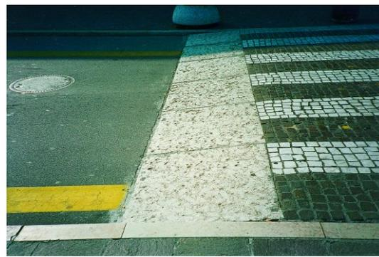
Figura 10-13: Esempio di realizzazione e segnalazione delle platee rialzate
