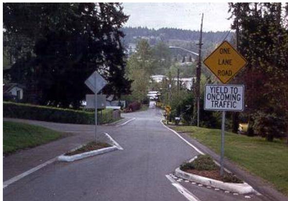
Figura 10-19: Schema di restringimento inclinato ed esempio a Bellevue, WA
