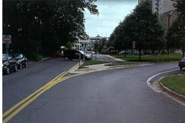
**Figura 10-9: Schema con isole di obbligo di svolta ed esempio a Montgomery County, MD**
