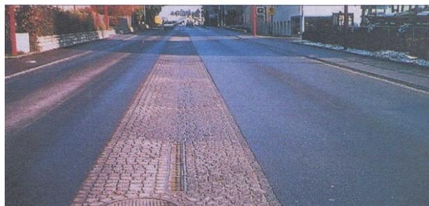
Figura 10-22: Schema di corsia polivalente ed esempio in Belgio
