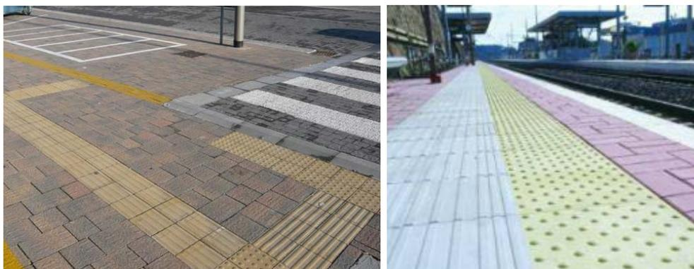
**Figura 10-3: Esempio di pavimentazione tattile in corrispondenza di un attraversamento pedonale e in una stazione**
