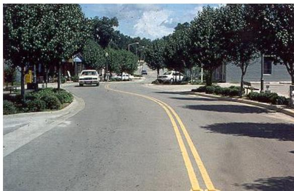
**Figura 10-16: Schema di chicane ed esempio ad Alachua, FL**
